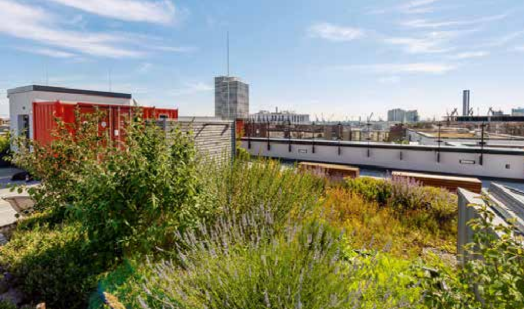
Dachbegrünung in der HafenCity (UC266, S. 28)
